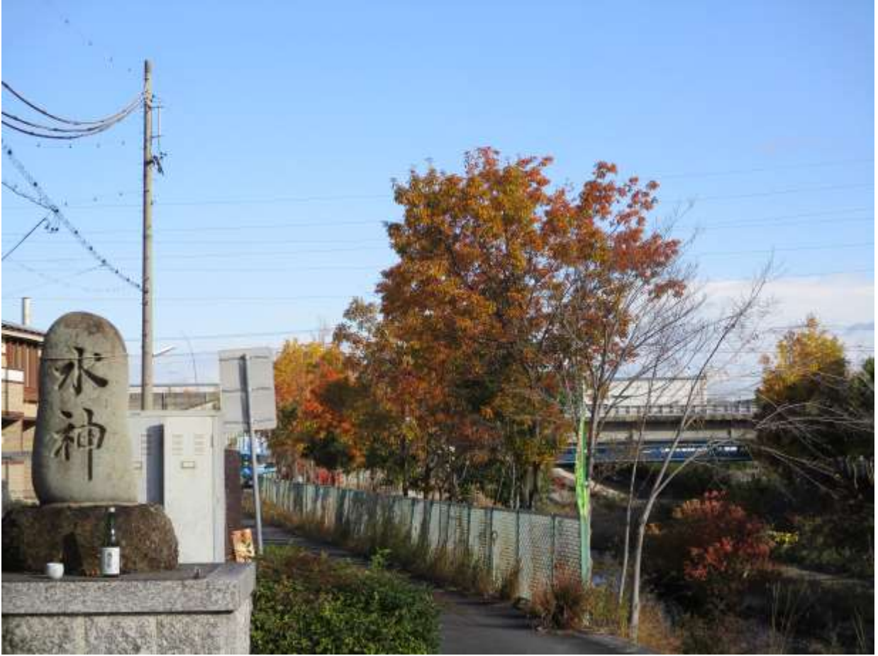
駒越橋の上流
