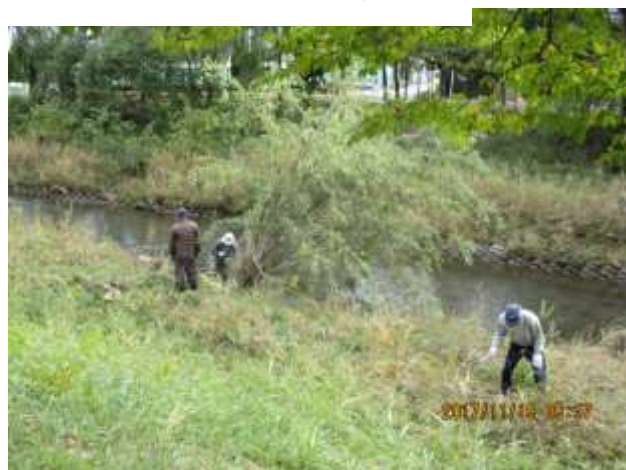
<右岸の雑木伐採>
